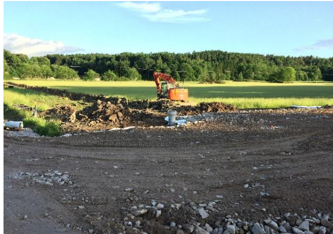
Ledningar för vatten och el har grävts ner och ytor som förväntas användas mycket har hårdgjorts.
