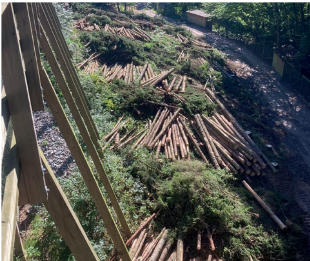
OMSTÄLLNINGSSARBETET PÅBÖRJAS I PARKEN
